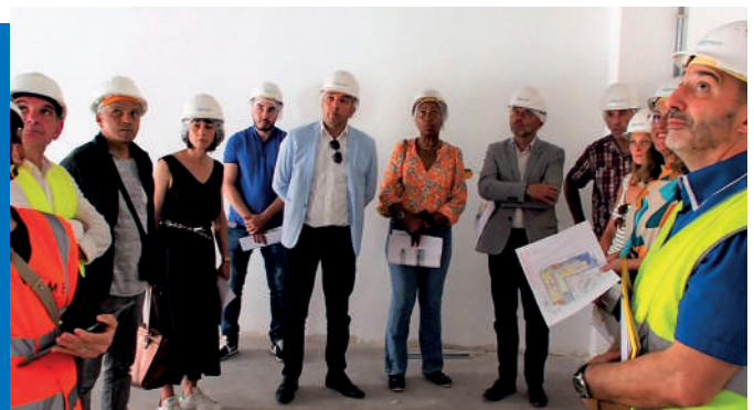
Monsieur le Maire Métin YAVUZ entouré de Mme Éveline BOUTON et M. Kamel BELKHIRI, maires adjoints, et des services de la Ville, lors de la visite de M. Éric HAVARD, Inspecteur de l'Éducation Nationale, sur le chantier de la nouvelle école maternelle Paul Éluard le 8 juin dernier.
